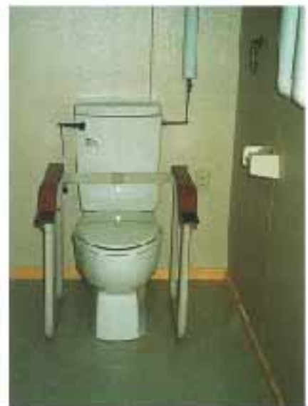
トイレにはつかまる手すりがある
