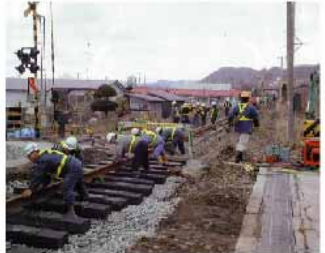
線路の復旧工事
