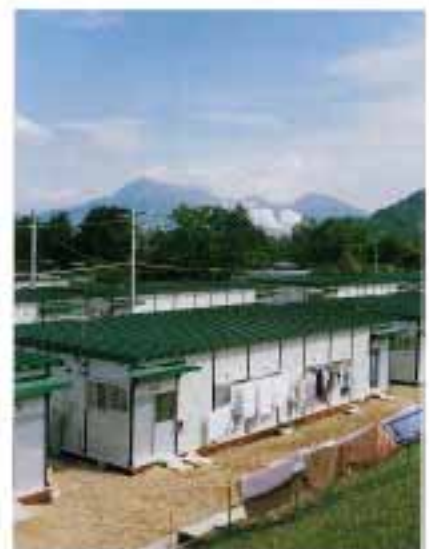
月浦地区の仮設住宅
