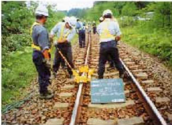
線路の強化工事
