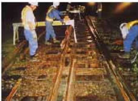
工事は、夜あそくまで行われた
