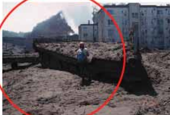
ひびき 地殻変動でガタガタになった道路
