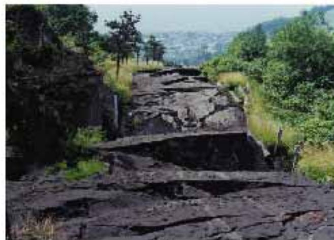
ひびき 地殻変動でガタガタになった道路
