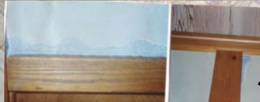
平成15年の地震による被害 (壁のはがれ落ち)
