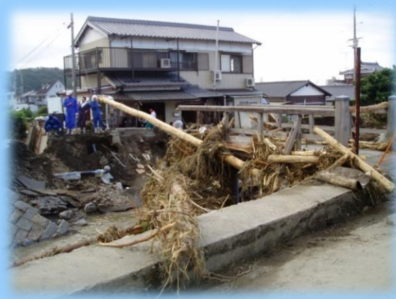
尻無川・政枝小橋
