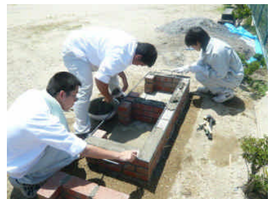
(f) 鉄枠を置き、モルタルを敷く
