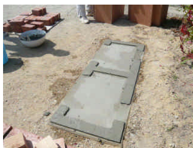
(b) 鉄枠にモルタルを詰める
