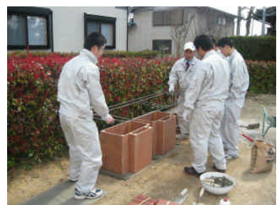
(c) 木枠を置き、鉄枠をはずす
