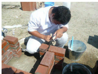
(e) 木枠をはずし目地を詰める
