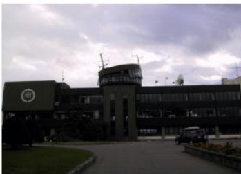
震度6弱の強いゆれでこわれた建物
