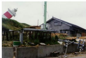
地震で倒れた電柱や灯台
