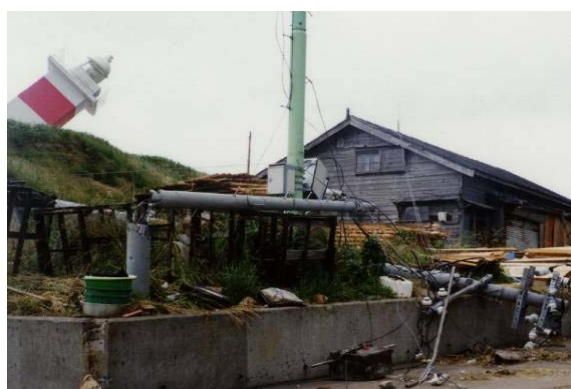
地震で倒れた電柱や灯台
