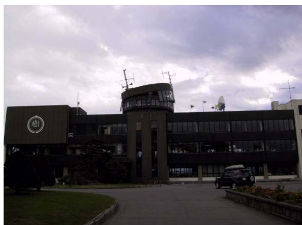
震度6弱の強いゆれでこわれた建物
